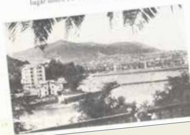
LEQUEITIO. Vista municipal de la Villa.
