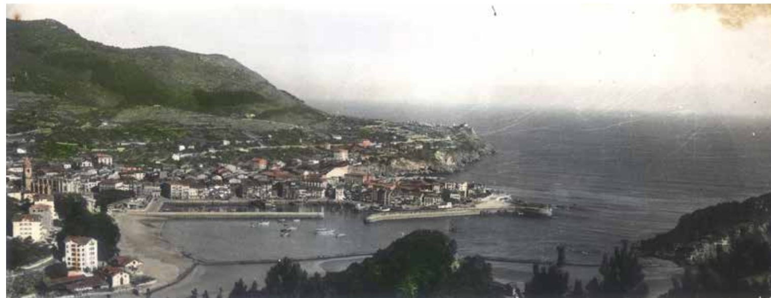
931. Lekeitio. Vista general. Ed. Arribas- Zaragoza
