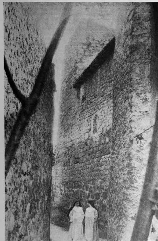
TORREÓN O ANTIGUA TORRE DE LICONA
