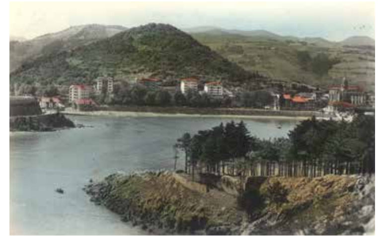
41. Lekeitio. Vista general. Ed. Arribas- Zaragoza
